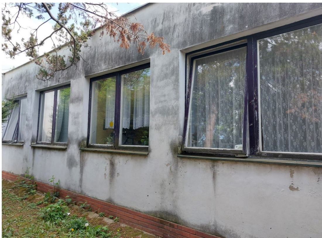
Obrázek 7 Budova N, původní dřevěná okna
